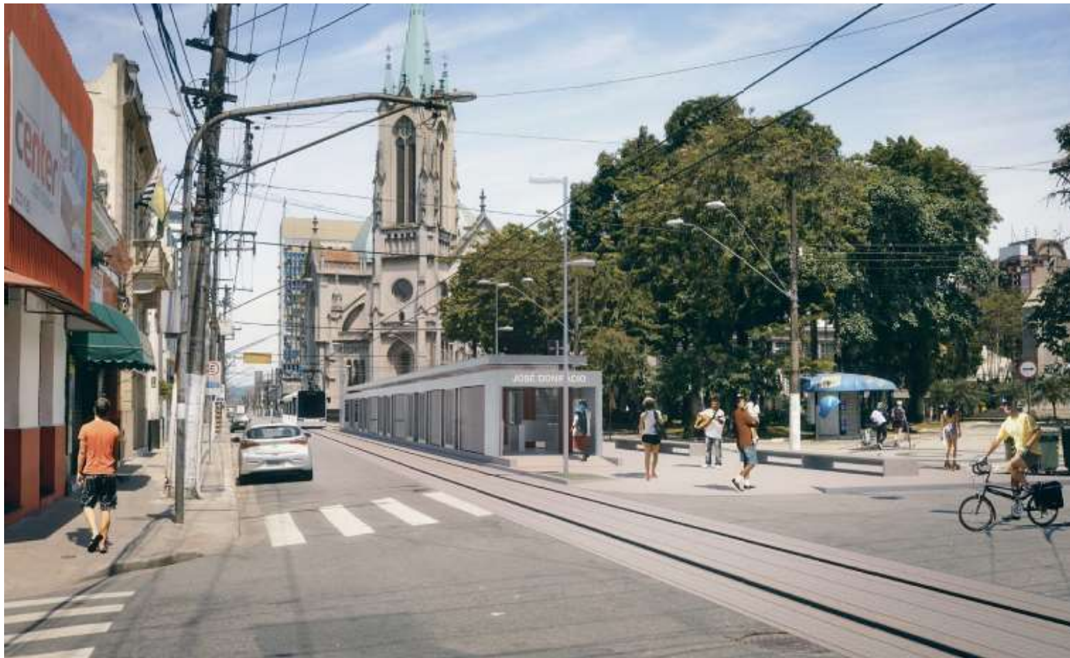
ESTAÇÃO JOSÉ BONIFÁCIO – RUA AMADOR BUENO
