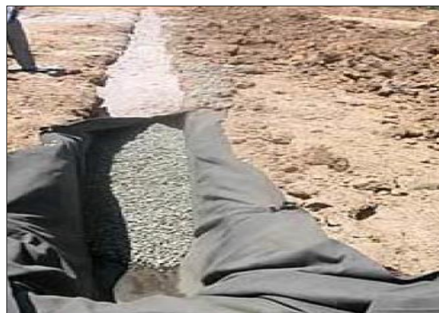
Foto 10.2.6-10: Canaleta de drenagem com manta geotêxtil e brita.
