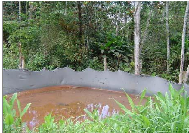
Foto 10.2.6-5: Bacia de sedimentação.
