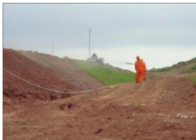
Foto 10.2.6-3: Cobertura vegetal (hidrossemeadura) para proteção de taludes.
