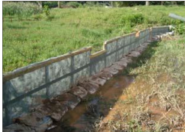
Foto 10.2.6-7: Barreira com vertedouro e linha de sacos de rafia, na base, para reforçar a estrutura
