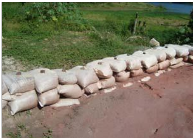
Foto 10.2.6-6: Barreira de sacaria escorada com pontalotes de madeira, para contenção de material carreado
