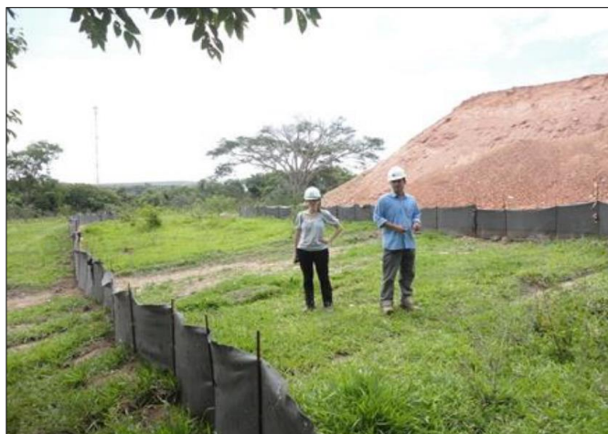
Foto 10.2.6-1: Cercas filtrantes no entorno de bota-espera
