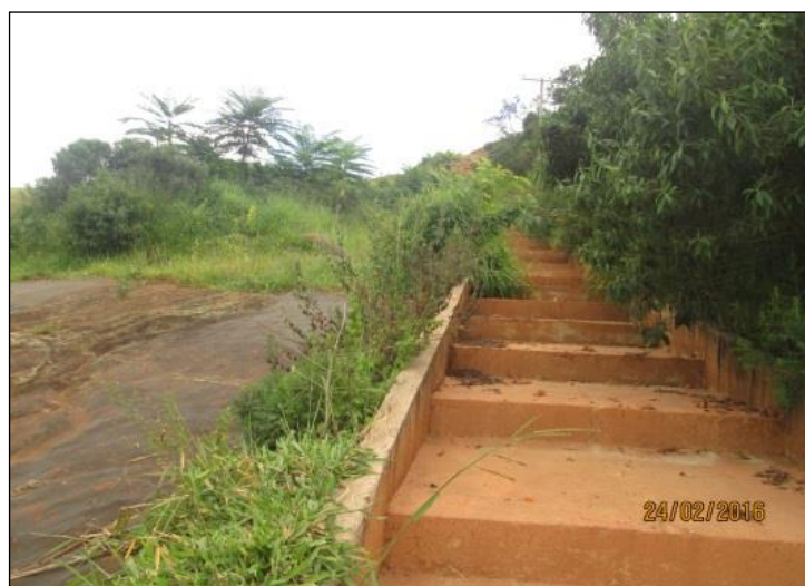
Foto 10.2.6-8: Escada hidráulica associada à manta geotêxtil em face de talude estabilizado.
