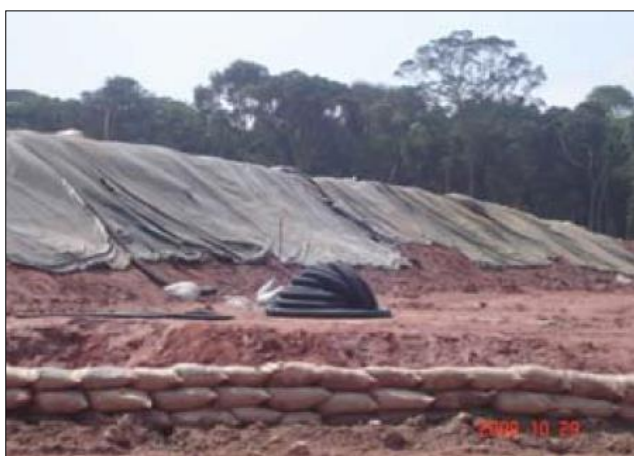
Foto 10.2.6-2: Uso de lona para proteção de taludes desprovidos de vegetação
