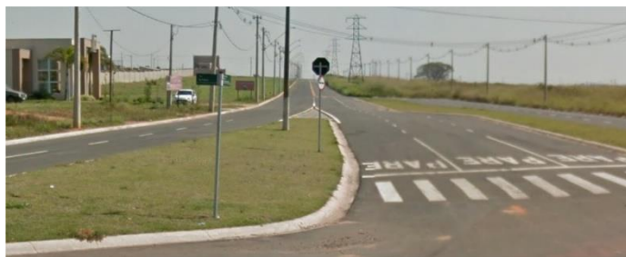
Prolongamento – linhas de transmissão de energia
